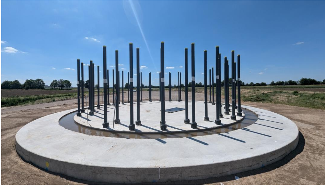
Foto: Fundament der Enercon-Anlage des Typs E-160
